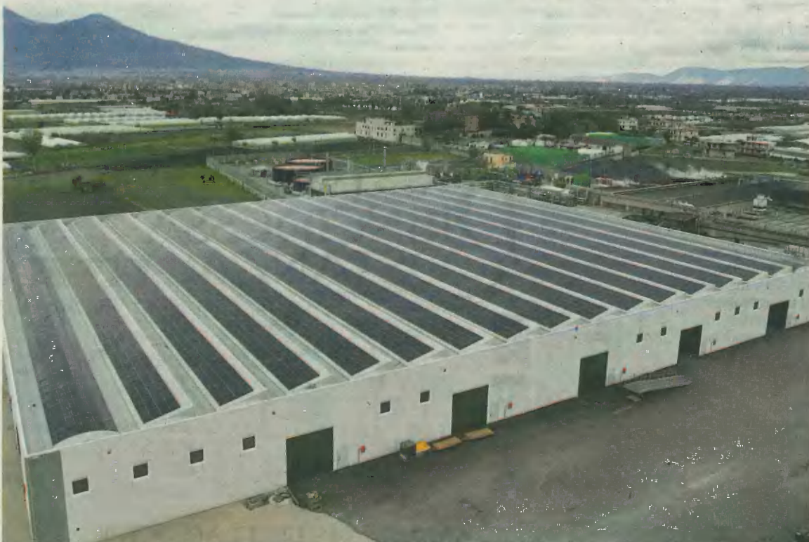
L'impianto fotovoltaico è uno dei gioielli tecnologici dell'azienda La Regina, non da meno il depuratore utilizzato
